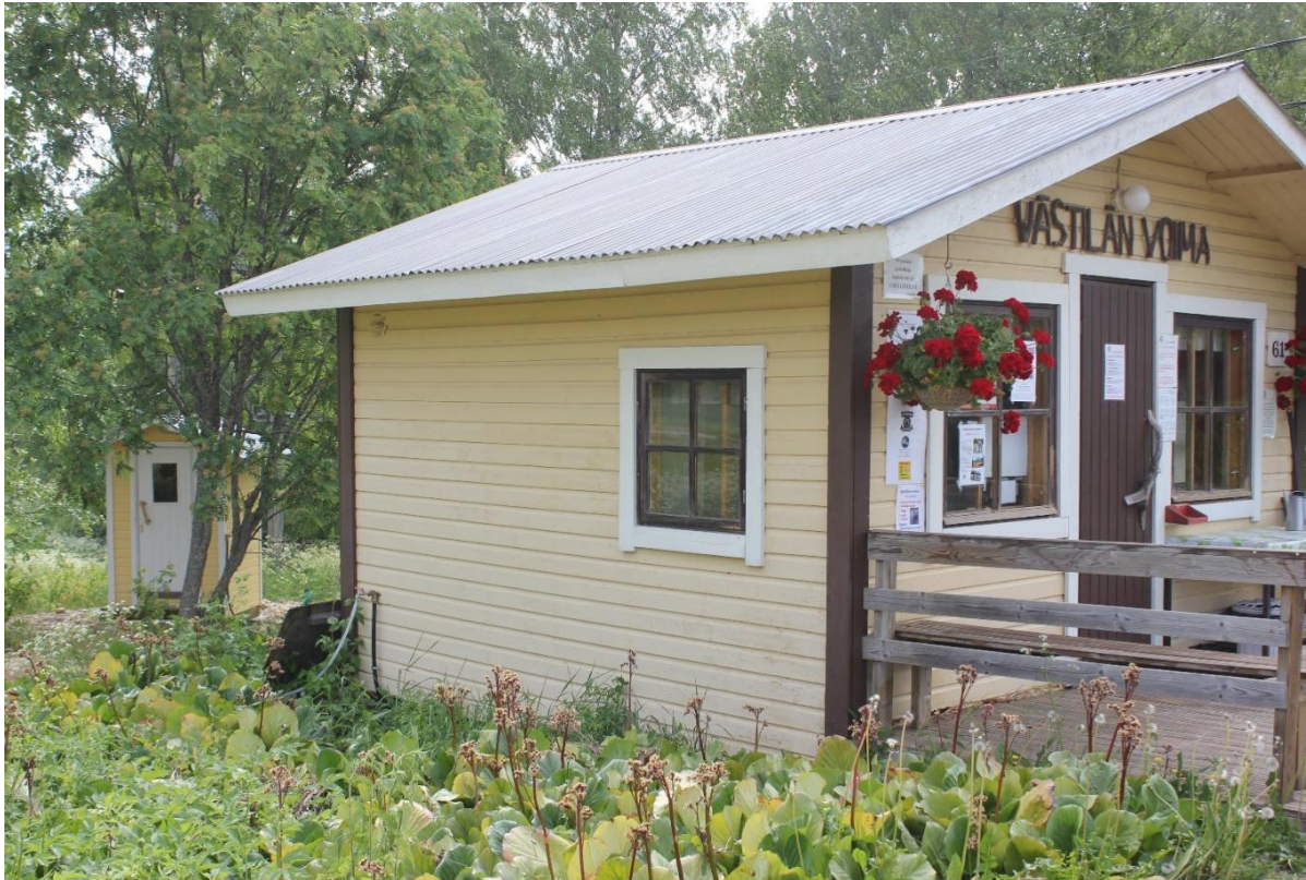
Kesäkioskille rakennettiin toukokuussa oma kompostoiva vessa
